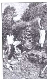
Un chantier de réparation des murs sur les terrasses de vignes.
